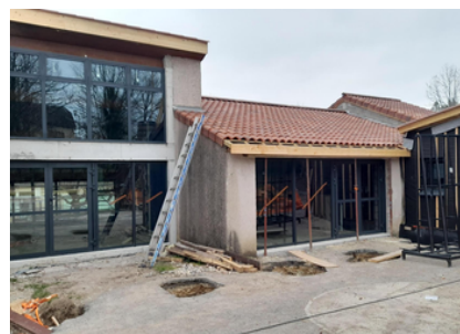
Travaux de la crèche à Montfaucon
